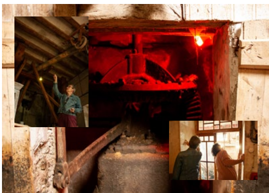
Ja a finals del segle XIX aprofitava l'aigua d'aquest riu per produir electricitat, és la central que està situada a la part més baixa del Fumal, i és en ella on es troba el motor que acciona el primer generador d'electricitat a La Pobleta de Bellvís.
